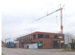
Nieuwbouw Spar Zelem
